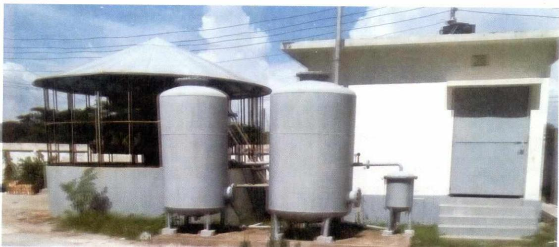
চিত্র: একাডেমীর সিআইডব্লিউএম কর্তৃক টিটিসি, গোপালগঞ্জে স্থাপিত গভীর নলকূপ ও ওয়াটার ট্রিটমেন্ট প্লান্ট
